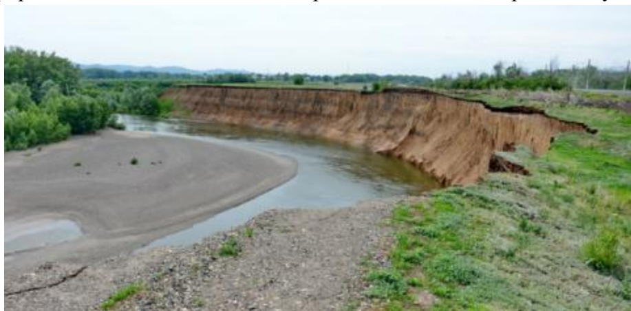
Рисунок 7 – Угроза разрушения железнодорожного полотна излучиной р.Сакмара у с. Жёлтое (2017 год)
